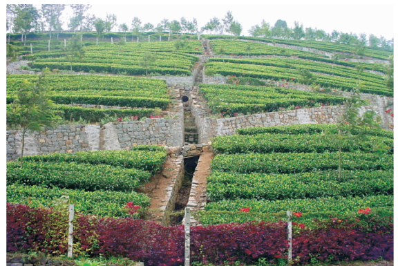
नीलगिरी पहाड़ियों में चाय वृक्षारोपण क्षेत्र के अंतर्गत अपवाह के सुरक्षित निकास हेतु ऊर्ध्वकार निकास मार्ग
