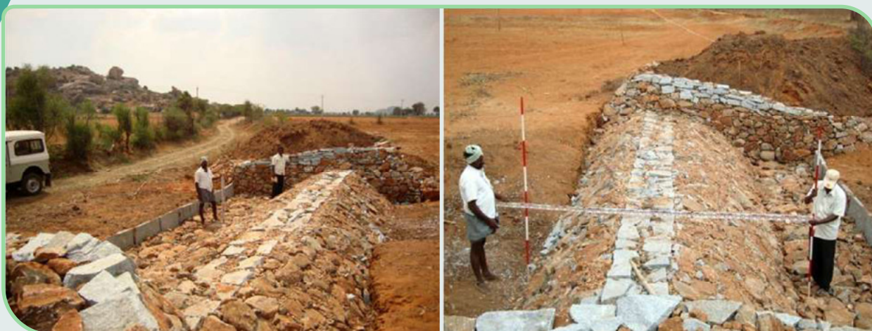
Fig. 5.9. Rock Fill Dam
