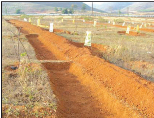
Trenching cum bunding
