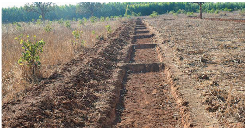
Trench cum bund in aerable land
