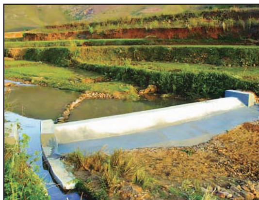
Masonry diversion cum check dam
